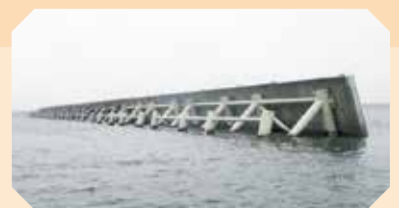
▲市川漁港に設置された防波堤
