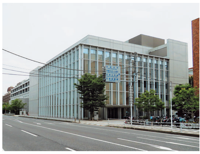
PF方式が採用された複合施設「市川七中行徳ふれあい施設」
