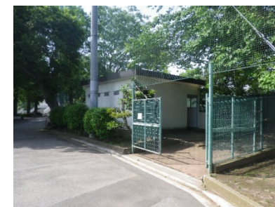
㉔野球場北東側トイレ
