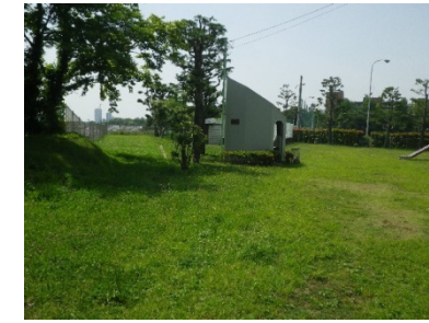
⑪北東側緑地部にあるトイレ
