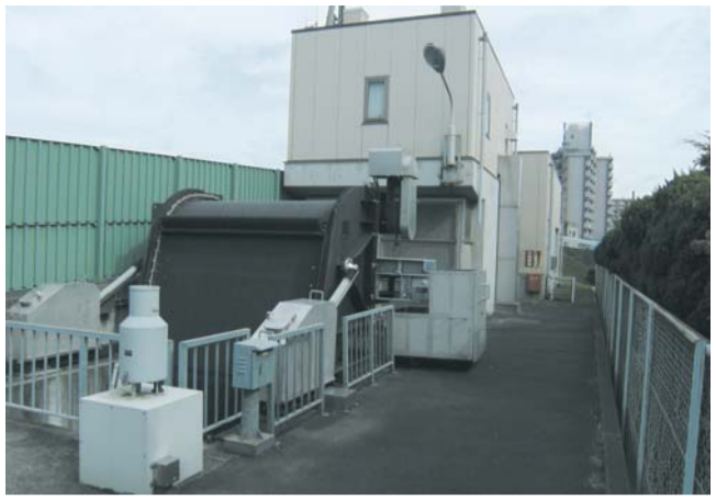
北原木排水機場
