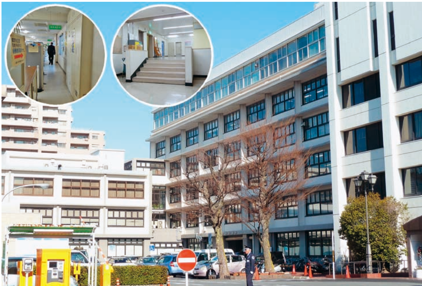
建て替えの基本方針を策定することが決まった本庁舎（左上囲み）バリアフリー化が求められている本庁舎内の狭い通路や段差
