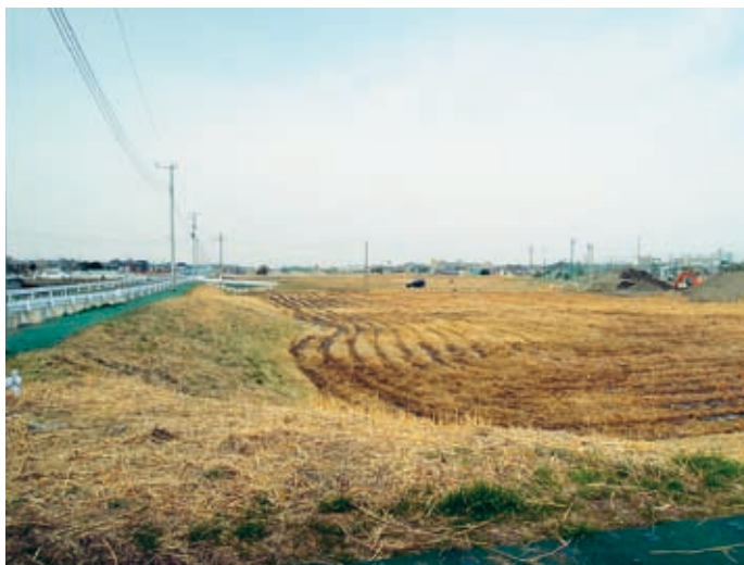
建設中の国分川調節池（中池付近）
