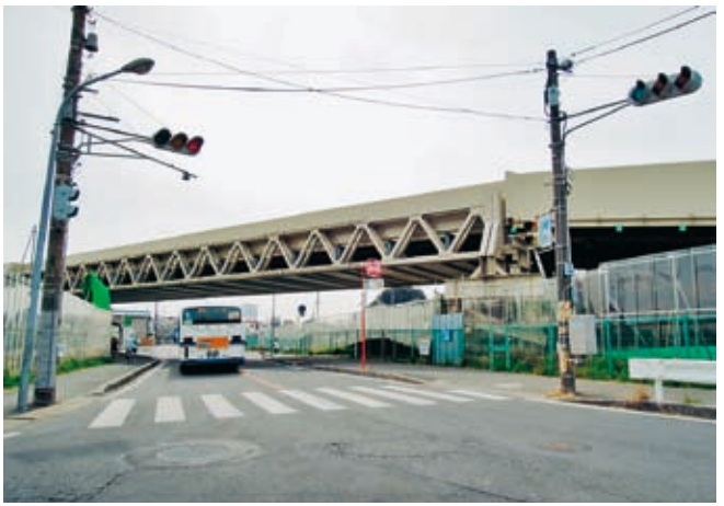
東京外郭環状道路工事 (国分5丁目付近)
