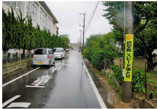
通学路の安全対策(信篤小学校前)
