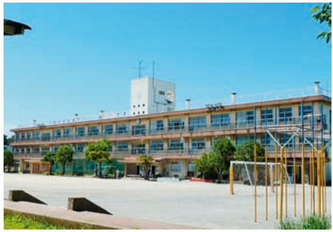
建て替えとなる国分小学校
