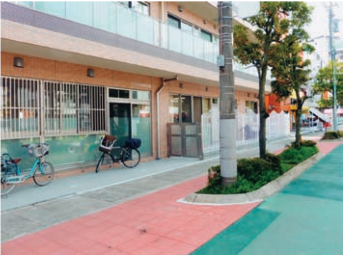
平成25年度は保育園3園を新設
