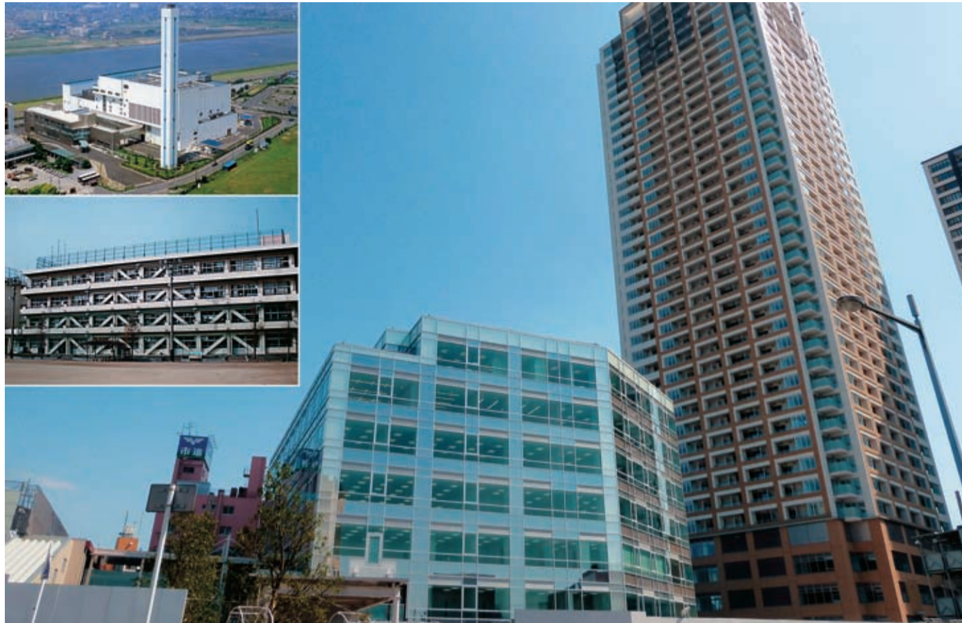
平成25年度中に完遂予定のビッグプロジェクト 本八幡駅北口A地区市街地再開発(I期工事) ＜左上＞クリーンセンター(延命化事業) ＜左中＞大野小学校(市有建築物耐震改修)
