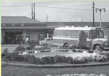
総武線の高架化(昭和45年)
