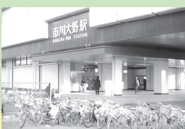
市川大野駅開業(昭和53年)
