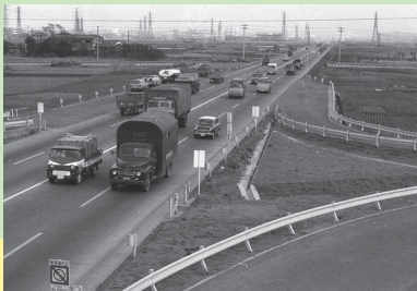
京葉道路・原木インターチェンジ (昭和40年)
