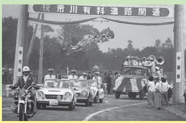
市川松戸有料道路開通(昭和43年)
