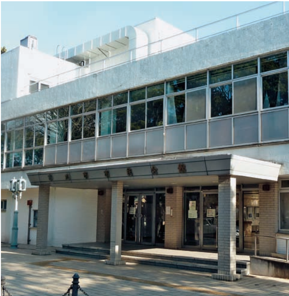
築54年が経ち、建て替えられることとなった市民会館
