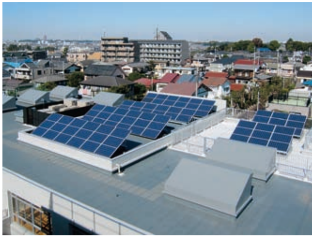
太陽光発電システム(第四中学校)
