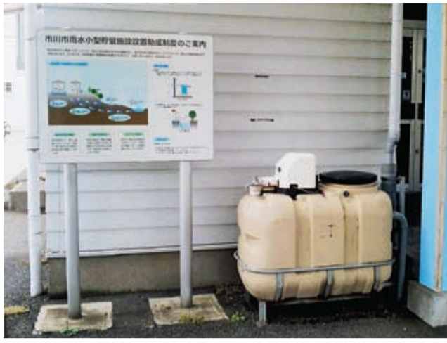
雨水貯留施設(浄化槽転用型・タンク部分は地中)
