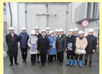
国道185号休山トンネル工事現場（呉市）
