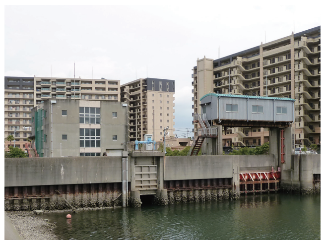
中江川排水機場
