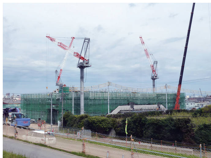
工事が進む大和田ポンプ場
