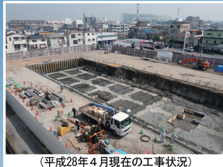
(平成28年4月現在の工事状況)
