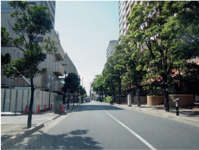
無電柱化された道路(市川南1丁目)
