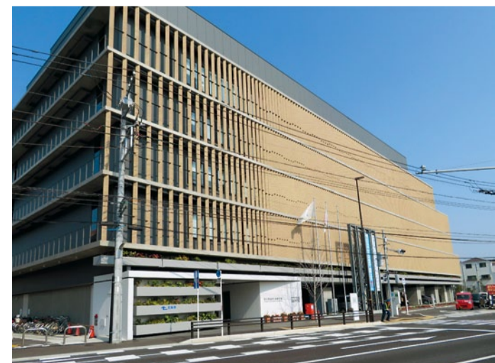
市川市役所仮本庁舎
