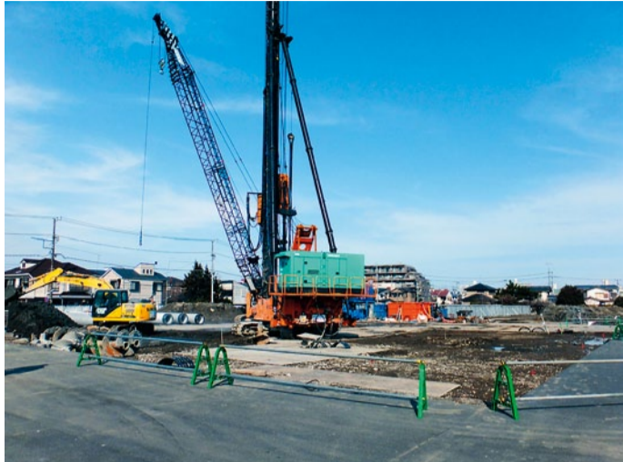
原木4丁目に新設される特別養護老人ホームの工事現場
