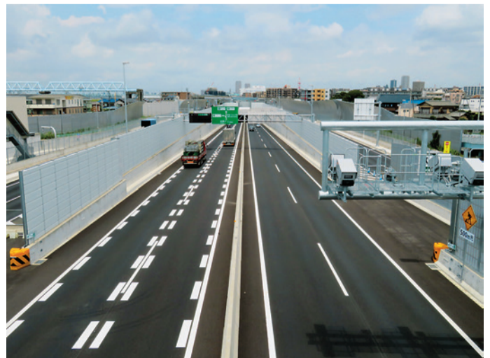
東京外環状道路(高谷3丁目付近)
