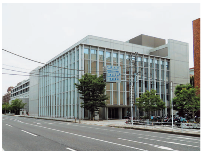
PF方式が採用された複合施設「市川七中行道ふれあい施設」
