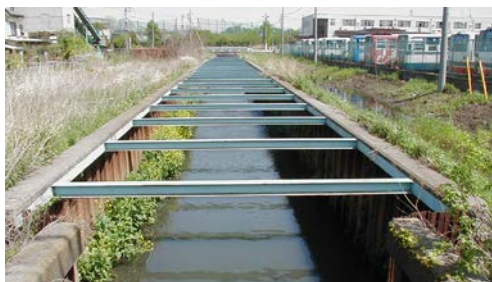
整備前：鋼矢板護岸
