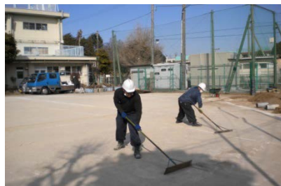
校庭表土の除去
