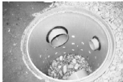
雨水浸透施設（浸透柵）
