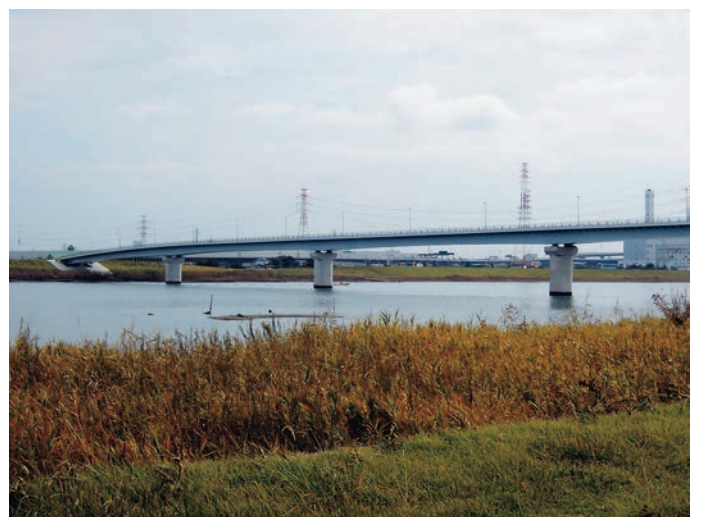
工事が進む(仮称)妙典橋
