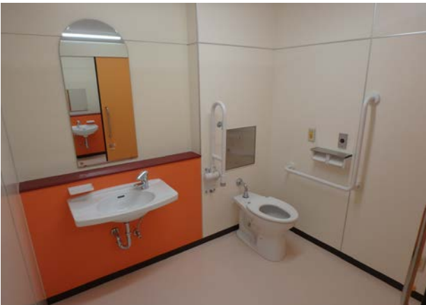
トイレ改修工事 中国分小学校
