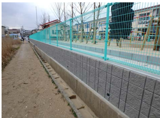
擁壁改修工事 百合台幼稚園
