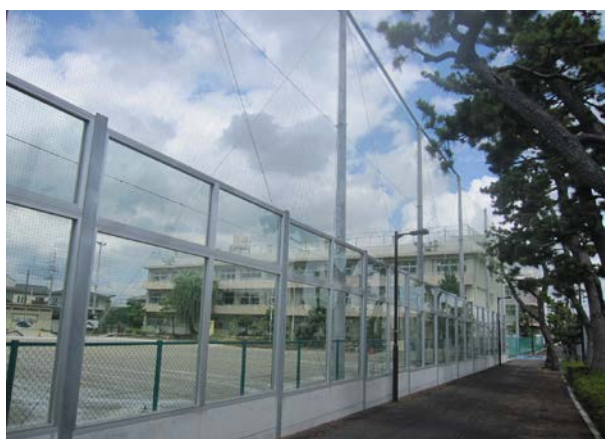
防球ネット等改修工事 富貴島小学校
