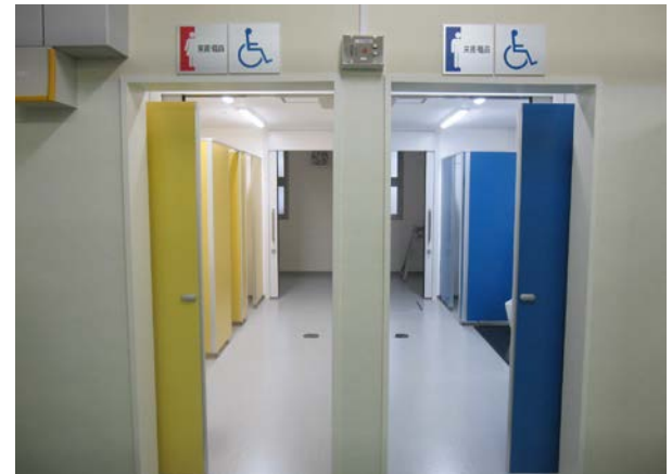
トイレ改修工事 富美浜小学校
