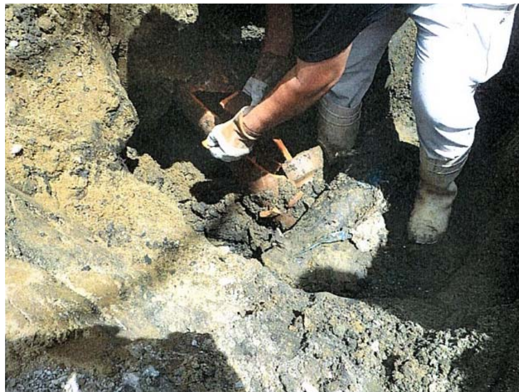
【取付管(陶管)破損状況】
