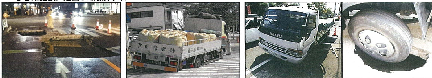
●管路施設に起因した陥没事故
