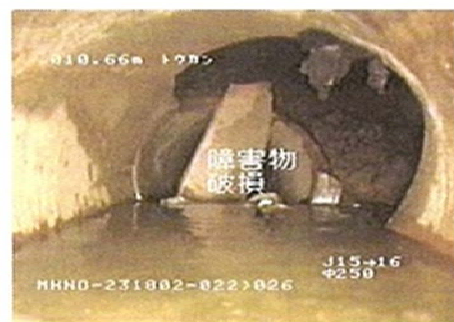
破損した管路
