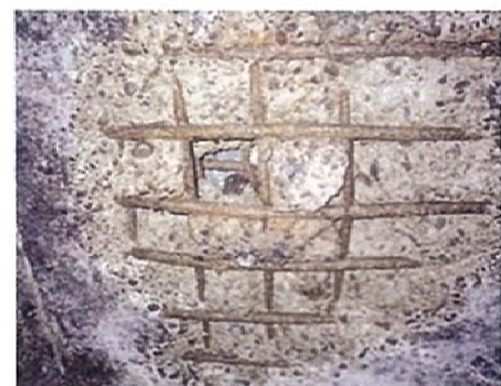
コンクリートが腐食し、鉄筋が露出した管路施設
