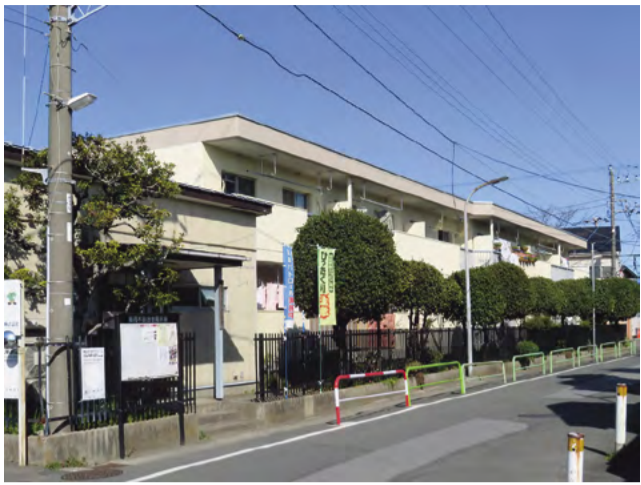
市営住宅(稲荷木団地)
