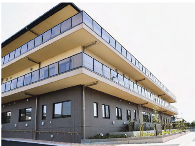
平成31年3月にオープンした特別養護老人ホーム
