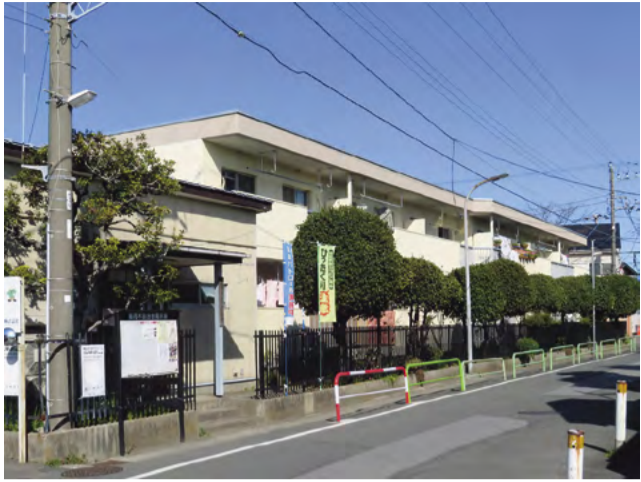
市営住宅(稲荷木団地)
