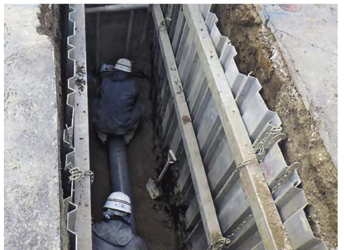
下水道管の敷設工事
