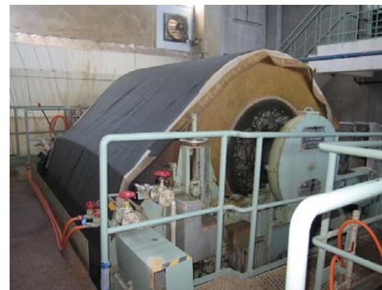
【供用開始時から使用している汚泥脱水機】
