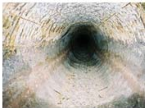
硫化水素による管路の腐食
