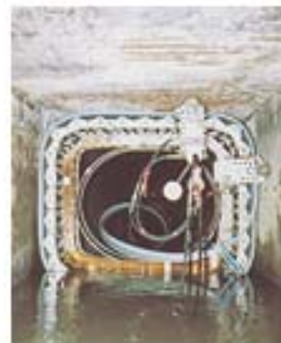
プラスチック材により既設管渠の内面を被覆
