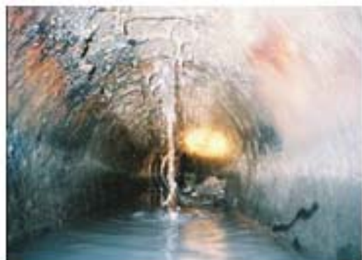
クラックからの侵入水
