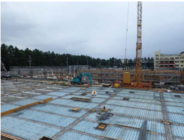
塩浜学園 新築工事 施工写真
