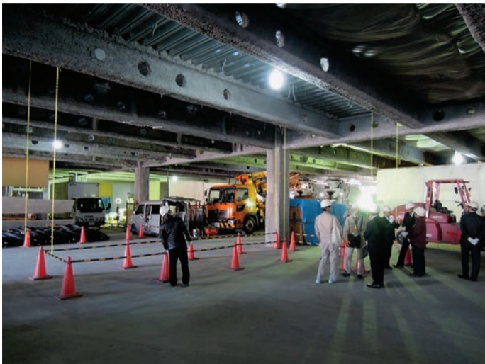
工事が進む市役所新第1庁舎(内部)
