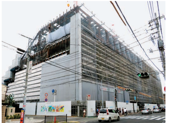
工事が進む市役所新第1庁舎(南西側)
