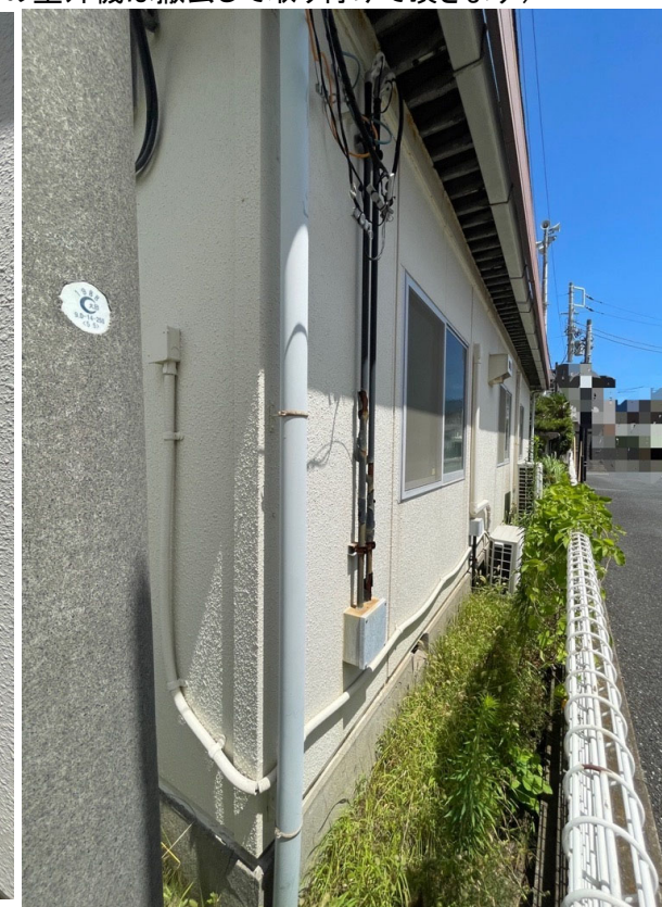
建物裏側から撮影
