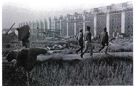
行徳駅近くの東西線 こうじ 工事のようす （昭和42年）
