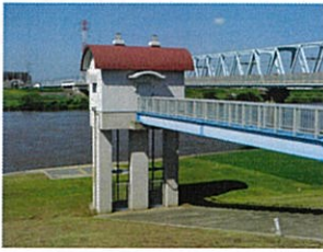
・取水ゲート
