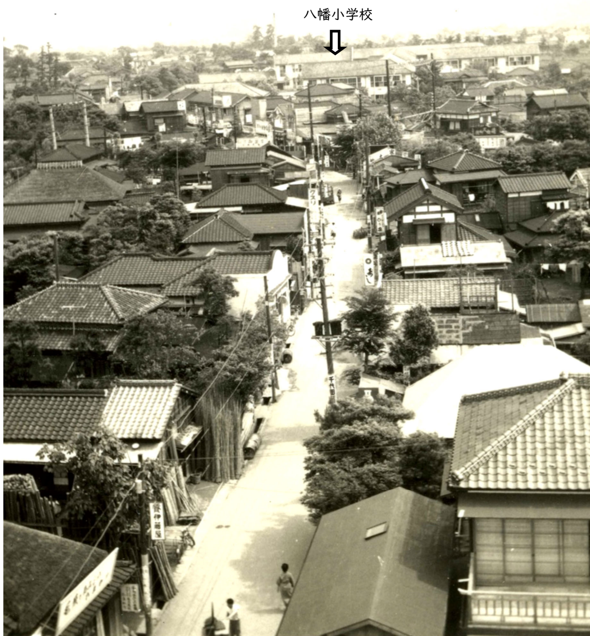
ごう やわた ほうめん 国道14号線ぞいから八幡小学校方面のようす しょうわ (昭和30年ごろ・70年くらい前)
