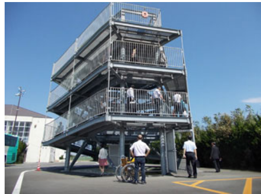
新しく作られた津波避難タワー
