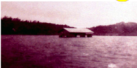
水につかった小屋 (印西市立印旛歴史民俗資料館)
