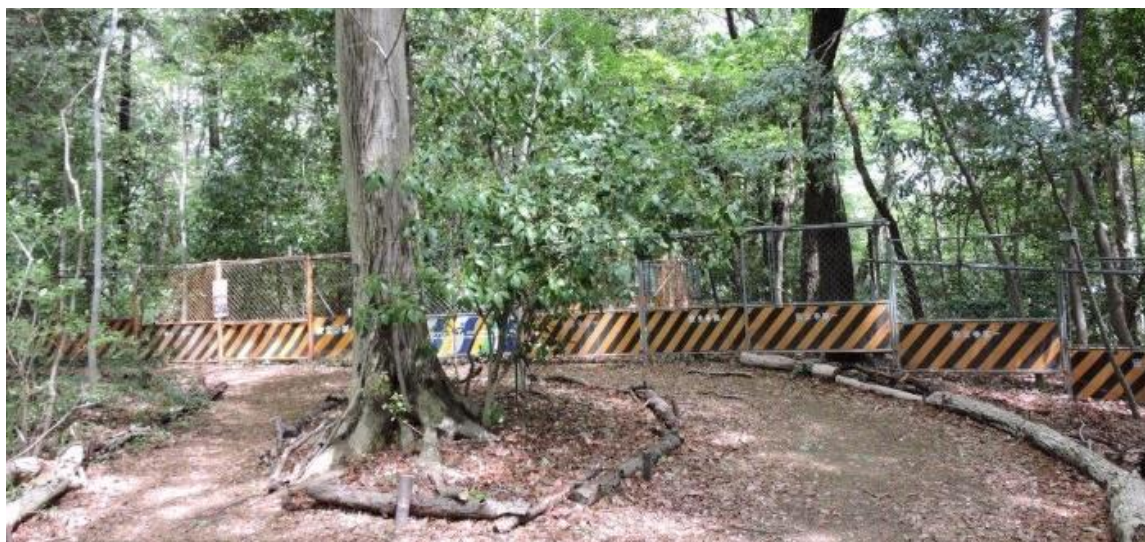
バリケードにより立ち入りが出来ない部分がある 2017年4月18日撮影
