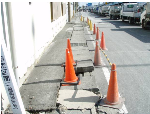
側溝の破損
