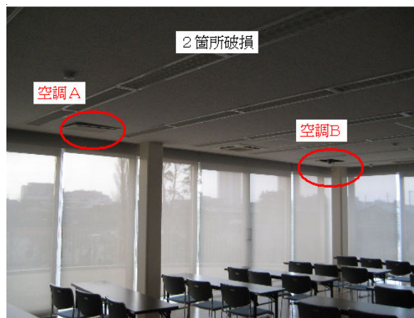
大洲防災公園管理棟
