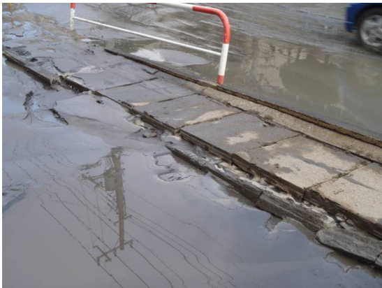
地盤液状化による道路の冠水
