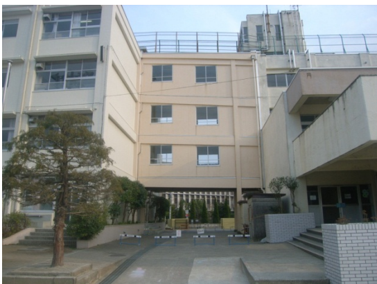
北方小の渡り廊下の破損
