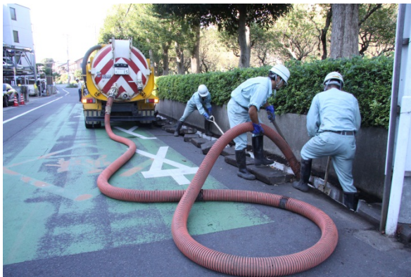
道路側溝の清掃
