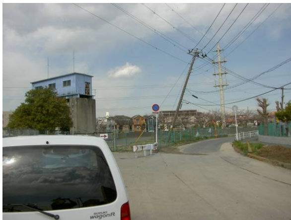
液状化により傾いた電柱
