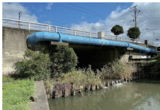
△修繕工事 (塩浜橋)
