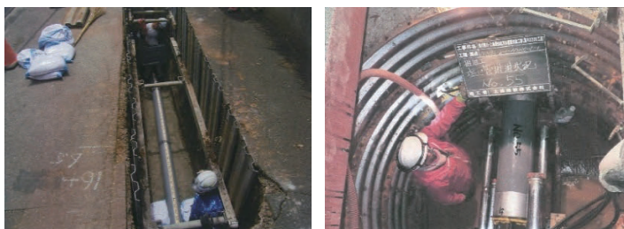
△下水道管渠布設工事（施工例）
