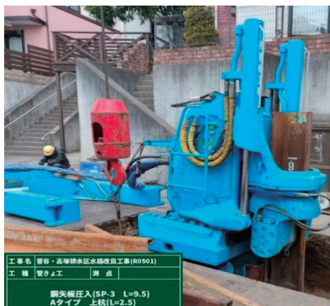
△鋼矢板打設状況
