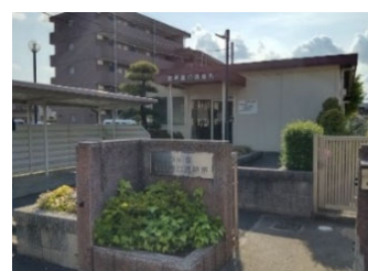
信篤窓口連絡所（築34年）
