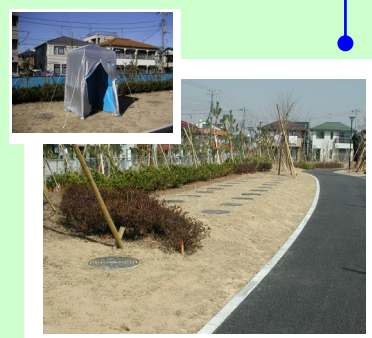
非常用便槽 25ト1基 20ト1基 ブースを組み立てて利用
