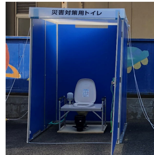
[マンホールトイレの設置] 7
