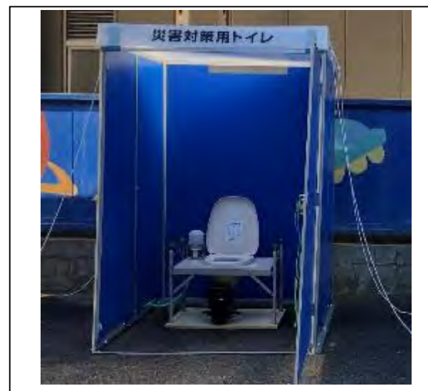
[マンホールトイレの設置]
