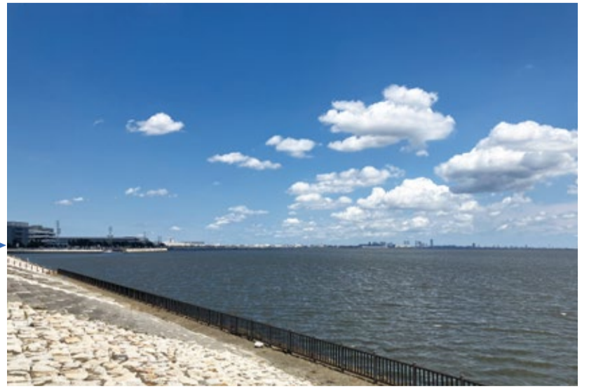
▲緩傾斜・階段護岸(令和3年10月完成)
