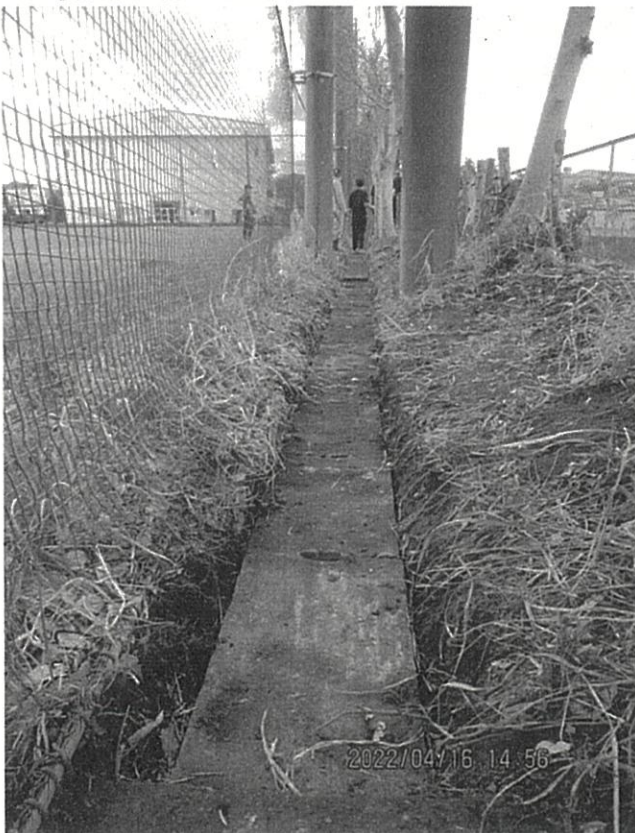
⑭側溝蓋を閉めて元に戻しました
