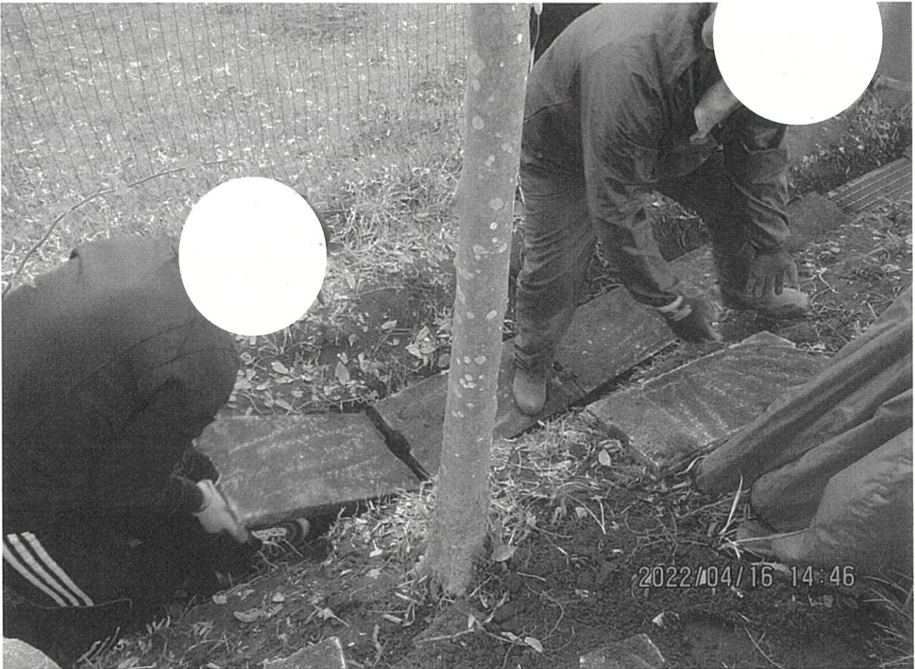
⑬側溝蓋を閉めて元に戻しました
