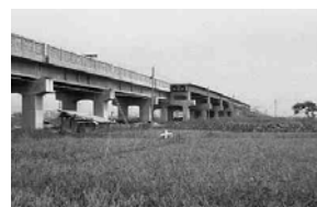
昭和43年 営団地下鉄東西線 (湊新田付近)
