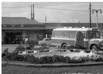
昭和 40 年 市川駅北口 駅前広場
