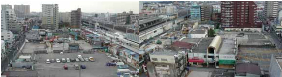
A 街区（東京寄り）
