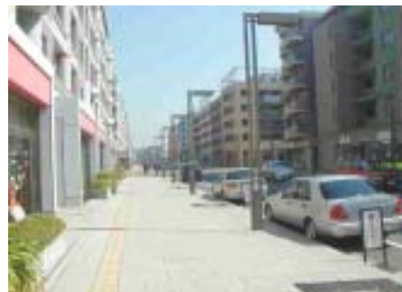
周辺環境に配慮した道路空間づくり (千葉市)
