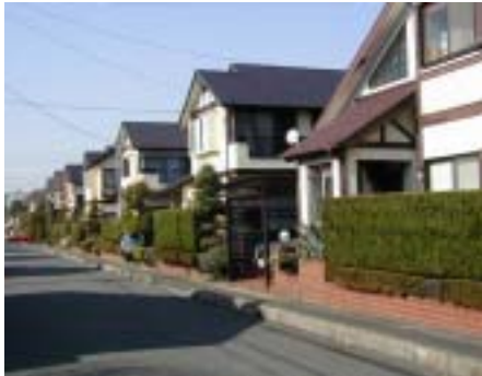
周辺環境との調和に配慮した住宅のデザイン(浦安市)
