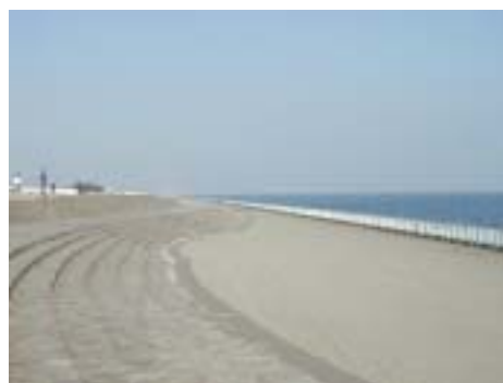
傾斜護岸による親水空間づくり (浦安市)
