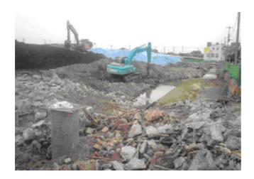
封じ込めるため、外周部分の地中の壁を造るうえで障害となる旧工場の大きな地下施設や硬いスラグなどを取り除く作業を行います。
