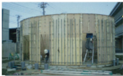
きれいな楕円となるよう、丁寧に型枠を組み立て
