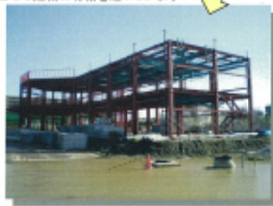
鉄骨を組み立てて建物の骨格を造っています
