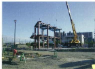
鉄骨を組み立てて建物の骨格を造っています
