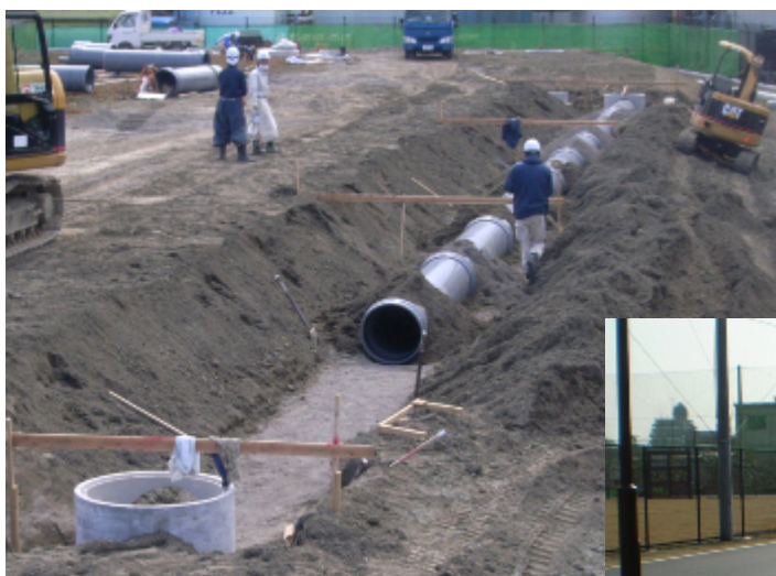
直径70cmの極太の管を地下に埋設しています
