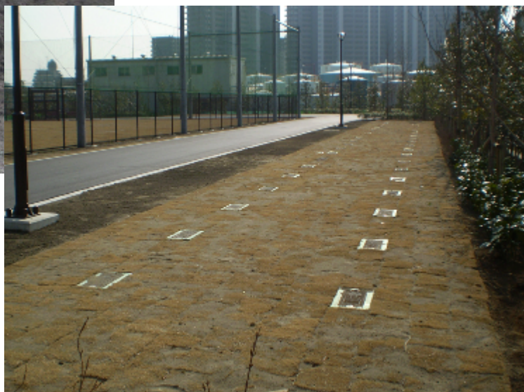
管の上に便槽となる小型マンホールを設置します
