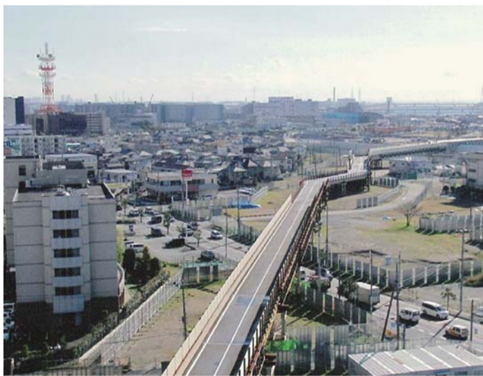
東京外郭環状道路工事用道路(仮橋)
