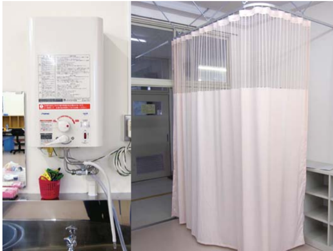
障害児用更衣スペースと温水器を整備した放課後保育クラブ
