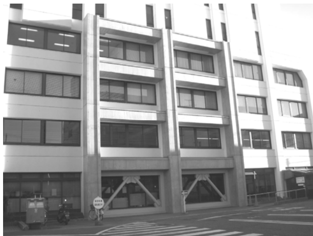
本庁舎の耐震補強工事
