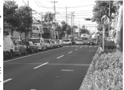
都市計画道路3・4・18号 (市川IC入口交差点付近)
